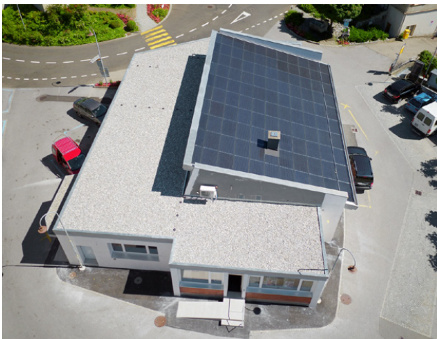
Photovoltaikanlage Bahnhof Walzenhausen.
